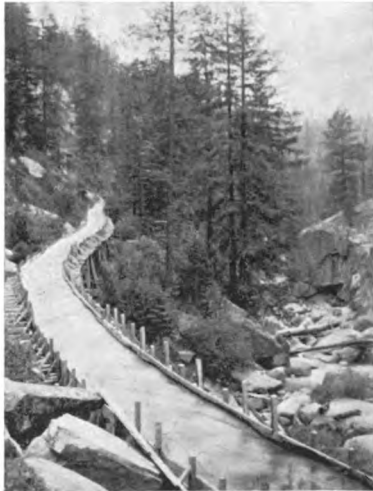
A FLUME OF THE TUOLUMNE WATER CO.
